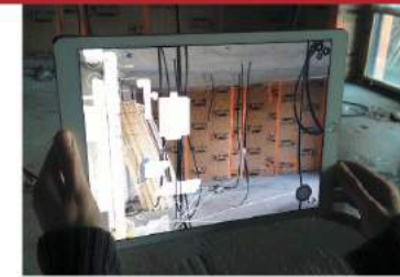
La réalité augmentée mixte in situ, une technologie prometteuse pour la communication en phase chantier, le contrôle qualité et l'exploitation d'un bâtiment.
